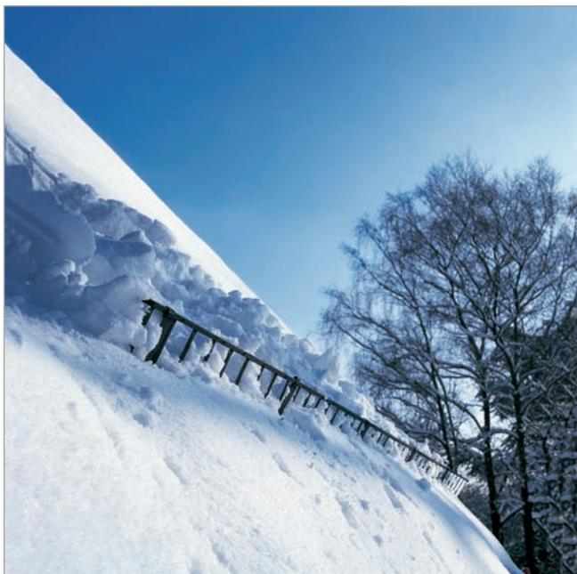
Trapac® système d'échelle de neige fait partie de la gamme de produits « sécurité de toiture » Klöber. Ce système est universel et offre une solution de protection fiable contre les glissements de masse neigeuse de la toiture. Il résiste aux charges conformément aux normes issues des codes du bâtiment et des expériences des charpentiers-couvreurs en zone enneigées.
